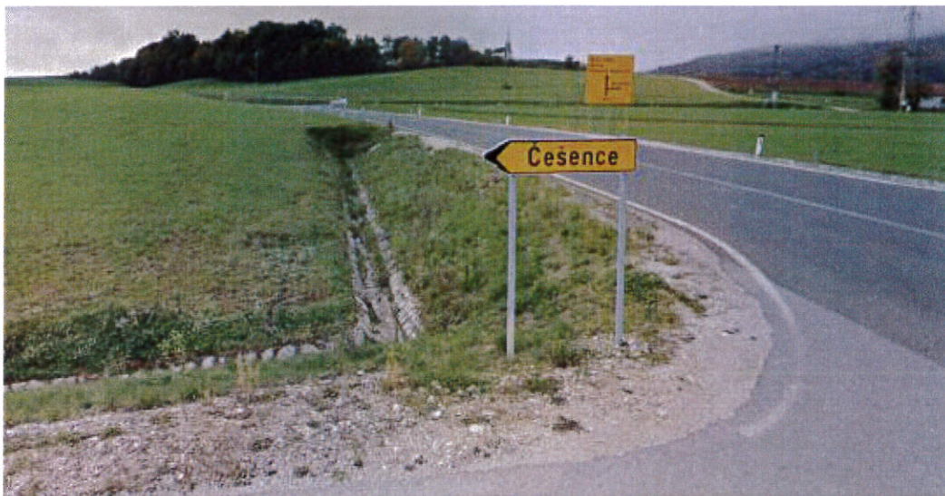
Slika 6: Pogled na obnovljeno regionalno cesto v smeri NM na začetku trase in na urejeno odvodnjavanje, kateremu se je s posegi potrebno izogniti
