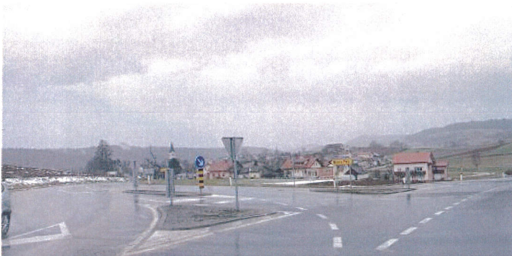
Slika 7: Pogled na obnovljeno križišče regionalne ceste in glavnega dostopa do Mirne Peči- lokalne ceste št. 425043
