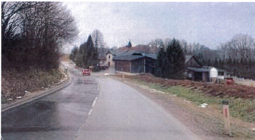
Slika 9: Pogled na regionalno cesto v smeri Šentjurij v km 0+580 (vas Rogovila)
