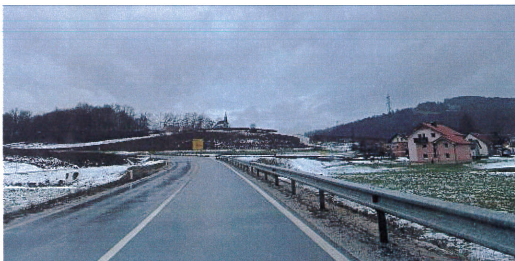
Slika 5: Pogled na obnovljeno regionalno cesto v smeri NM na začetku trase
