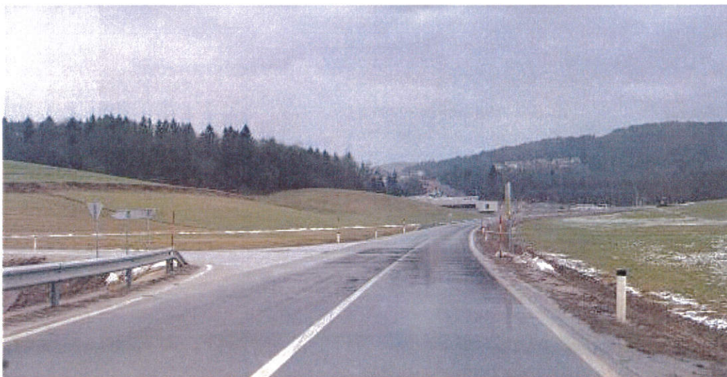
Slika 3: Pogled na regionalno cesto v smeri Šentjurij na začetek trase
